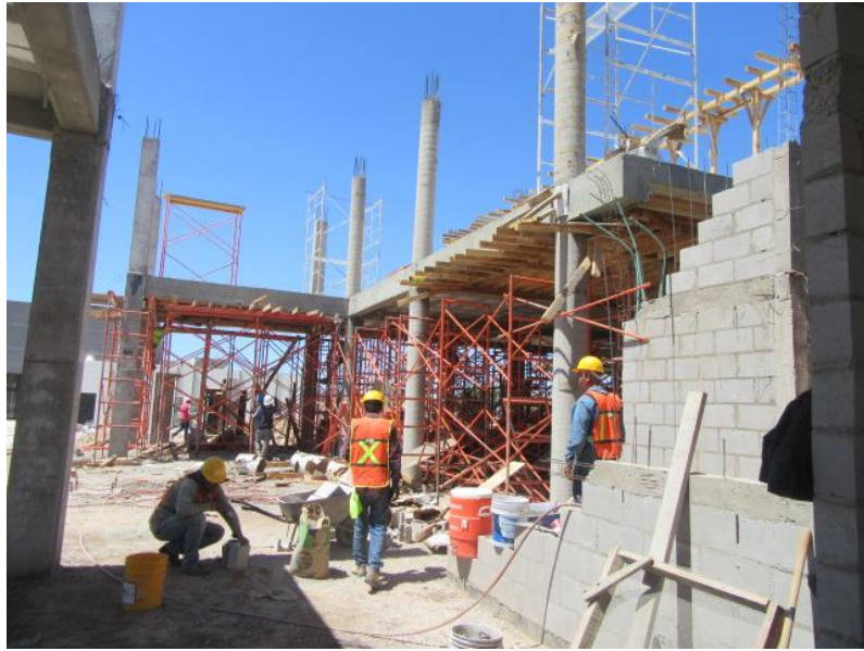
Construcción de edificio Sede Ministerial en la localidad y Municipio de Hermosillo.
